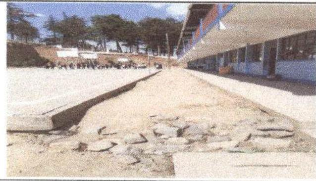
Foto 3: Reparación de piso de torta de concreto.
